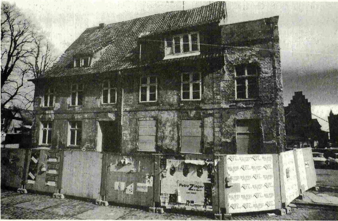
Das Haus Wasserstraße 80 – Alters-Patina versteckt noch seine ursprünglichen Reize – ein entschlossener Handwerksmeister hat sich vorgenommen, dem einst stolzen Gebäude seine ursprüngliche Qualität wiederzugeben.
