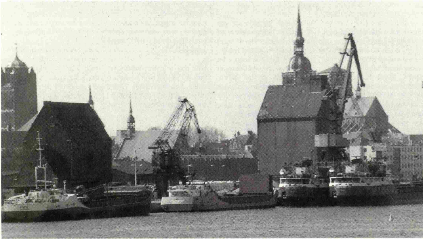
Der Seehafen Stralsund trägt nicht unerheblich zur wirtschaftlichen Wettbewerbsfähigkeit der Hansestadt Stralsund bei. Die zur Zeit durchgeführten Bauarbeiten werden diese noch verbessern.
