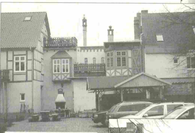
Frankenstraße 75, 75a, Bauherr: Karl Niemann, Sanierung betreut von Herrn Architekten Wolgast
