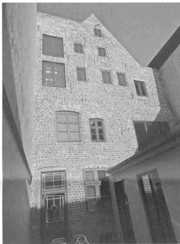
Rückwärtige Fassade Frankenstraße 40
