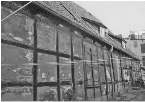
Heilgeistkloster Buden vor der Sanierung 1995
