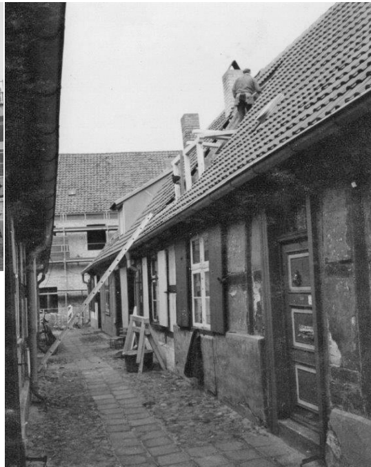
Heilgeistkloster Buden während der Sanierung
